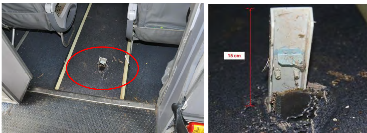
Foto 38: particolare del cross beam FR65.
