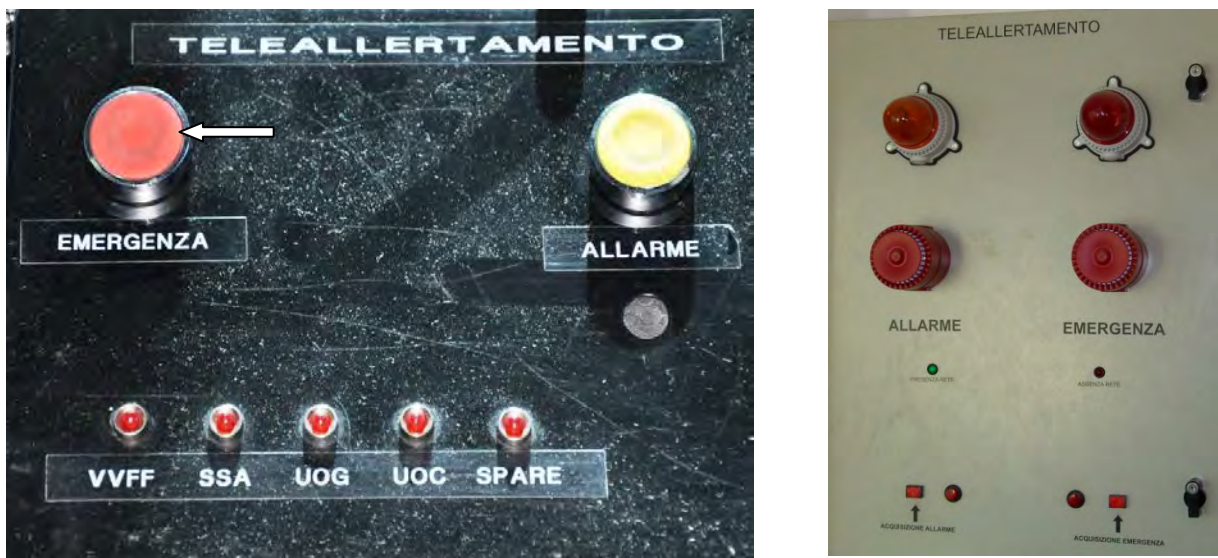
Foto 40: a sinistra, dispositivo di teleallertamento presente nella TWR; a destra, dispositivo di teleallertamento presente presso gli enti coinvolti nel PEA.
